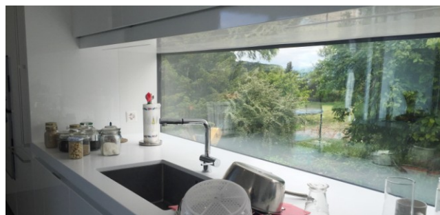
Fassadenbündige Verglasung bei einer Küche.
